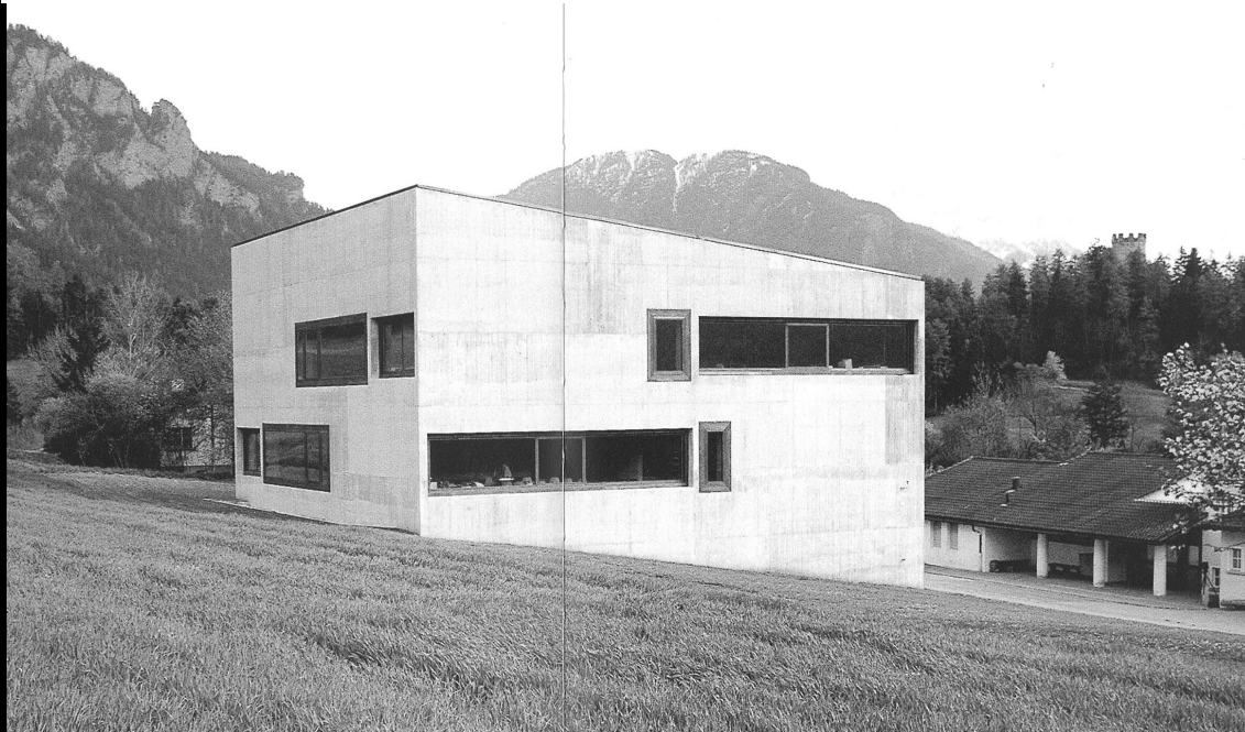
Aussenansicht Oberstufenschulhaus Paspels (1999)
