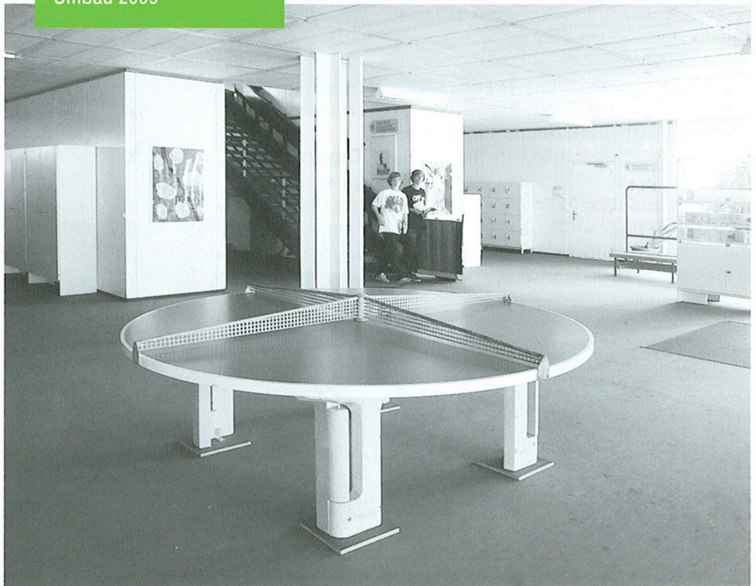
Grosszügige Erschliessungszone als vielfach nutzbares Raumangebot für Tagesstrukturen vor dem brandschutzbedingten Umbau 2009
