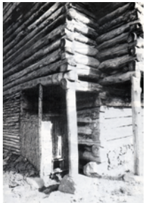
↑ zu Abb 83 : Detail der sorgfältigen Fügungstechnik der Rund- und Blockhölzer
