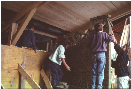
Abb 127 ⇒ Lehmbauepoche in einer 3. Klasse an der Rudolf Steiner Schule Zürich, Plattenstrasse. Nachdem der 2 Monate vor Baubeginn aus der Baugruube gewonnen und zu Lehmsteinen geformt wurde, werden hier die Wände errichtet. Links: Stampflehmwand mit Schalung, rechts aufgemauerte Lehmwand.
